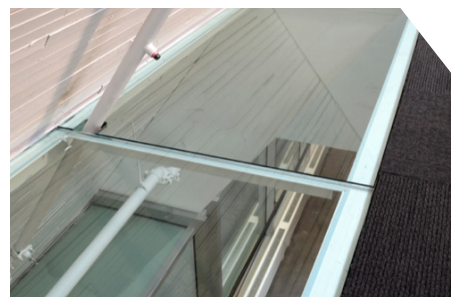
Plancher et escalier
